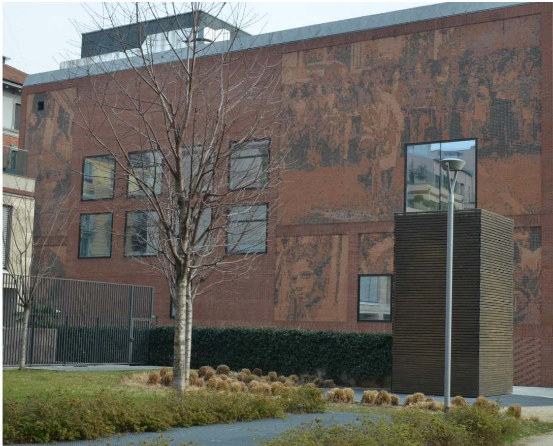
FIG. 32. Casa della Memoria, Milan (Baukuh, 2015), présentant sur ses quatre façades des reproductions en brique de photos d'archives. ( www.casadellamemoria.it/ )
